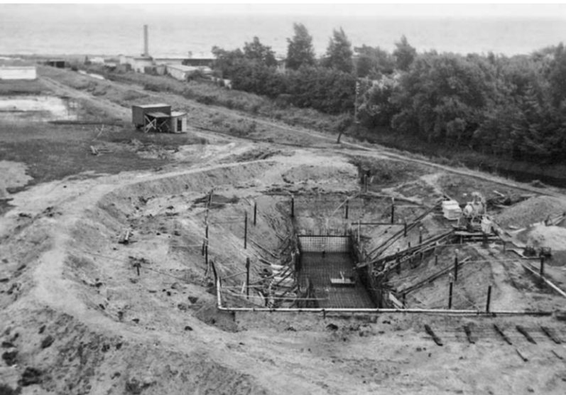
Fundamentene til slusen og pumpehuset ude ved Egåens udløb blev støbt under vanskelige vilkår, da entreprenøren måtte arbejde i flydesand. byggegruben blev holdt tør ved hjælp af en række lodrette borer i skråningssiderne, hvorfra vandet kunne pumpes væk. Slusen og pumpehuset er det vi kan se i dag og som stadig fungerer. Foto: Hedeselskabet.
