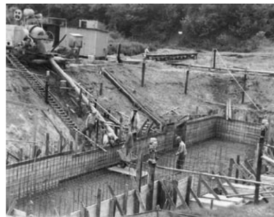
Fundamentene til slusen og pumpehuset ude ved Egåens udløb blev støbt under vanskelige vilkår, da entreprenøren måtte arbejde i flydesand. byggegruben blev holdt tør ved hjælp af en række lodrette borer i skråningssiderne, hvorfra vandet kunne pumpes væk. Slusen og pumpehuset er det vi kan se i dag og som stadig fungerer. Foto: Hedeselskabet.
