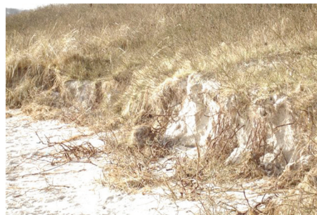
Erosion af digefod efter storm/højvande (Bellevue, Januar 2007).
