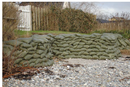
Midlertidig sikring efter storm/højvande (Platanvej, Januar 2007).
