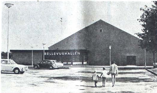
Gavt ved Ndr. Strandvej med hallens indgangsparti.
