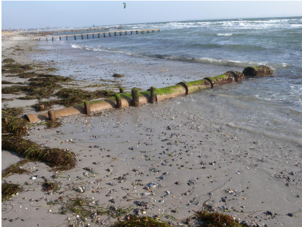
Figur 3.2.12: Udløbsrør i beton ved st. st. 3165.
