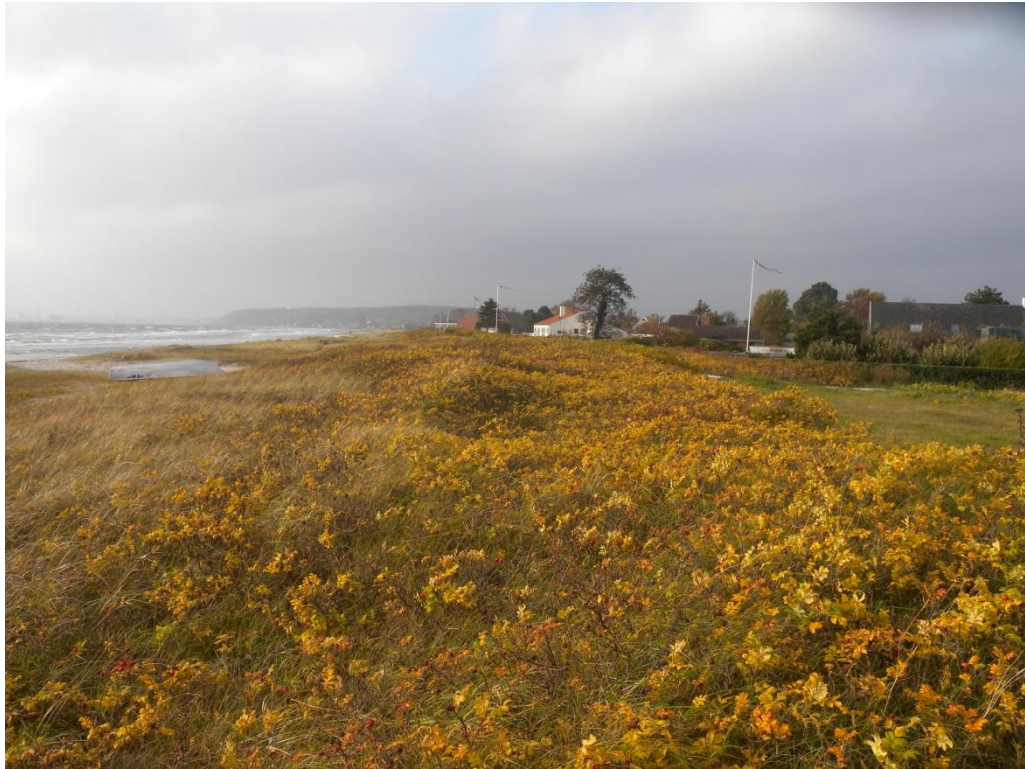
Figur 3.2.8: Foto mod syd af diget ved st. 2181.
