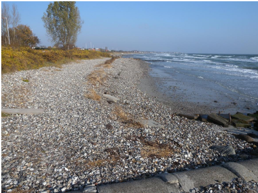
Figur 3.2.14: Foto mod nord af diget ved st. 3680. Bemærk den raldækkede forstrand.
