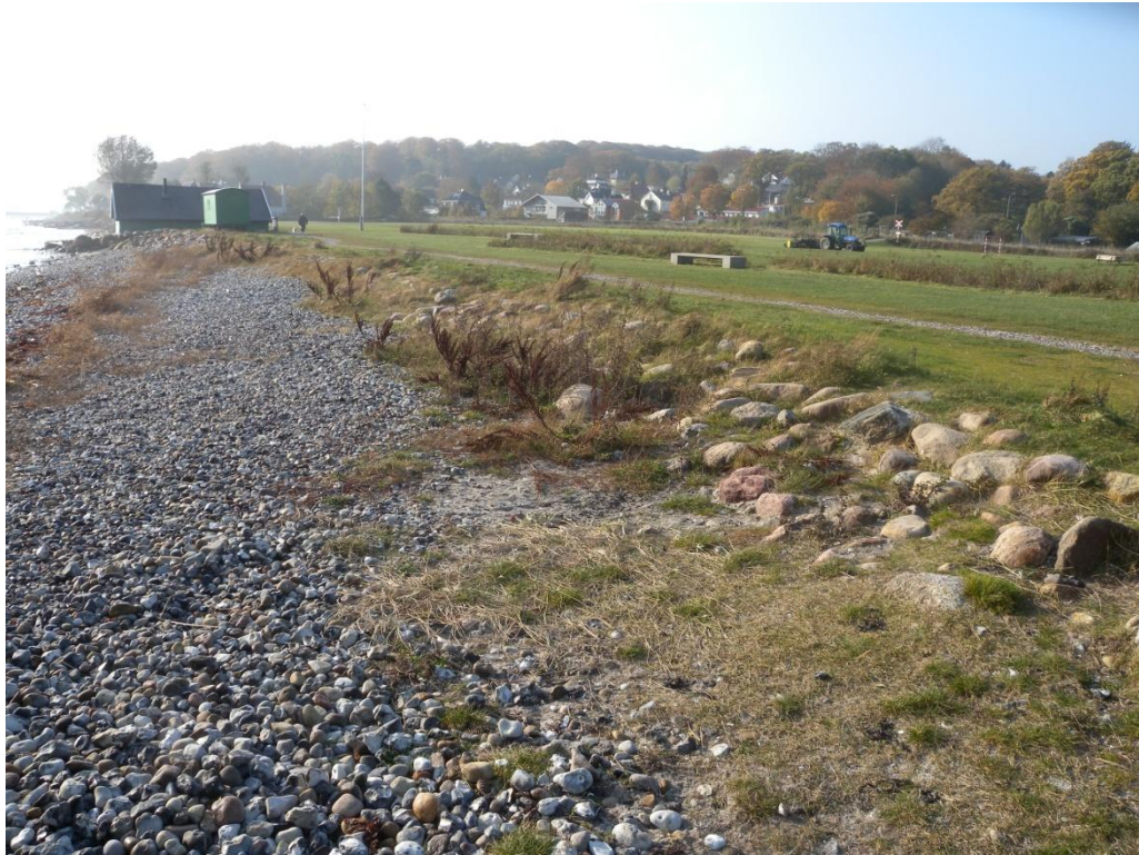
Figur 3.2.16: Foto mod syd af Hospitalsgrunden i digets st. 3860. Bemærk den raldækkede forstrand samt denstensikrede lave skråning.
