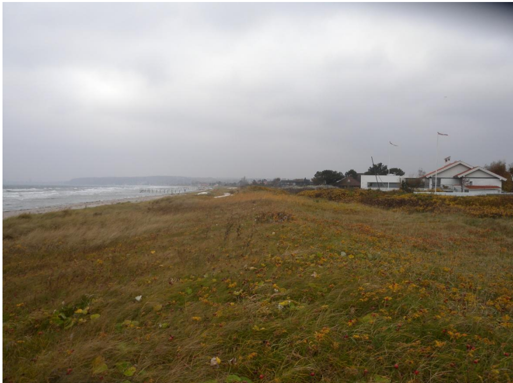
Figur 3.2.6: Foto mod syd af diget ved st. 1371.
