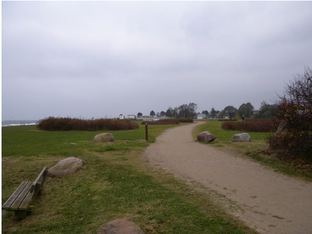
Figur 3.2.3: Foto mod syd af diget ved st. 202.
