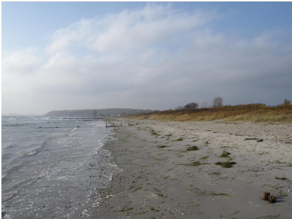
Figur 3.2.13: Foto mod syd af diget ved st. 2786.
