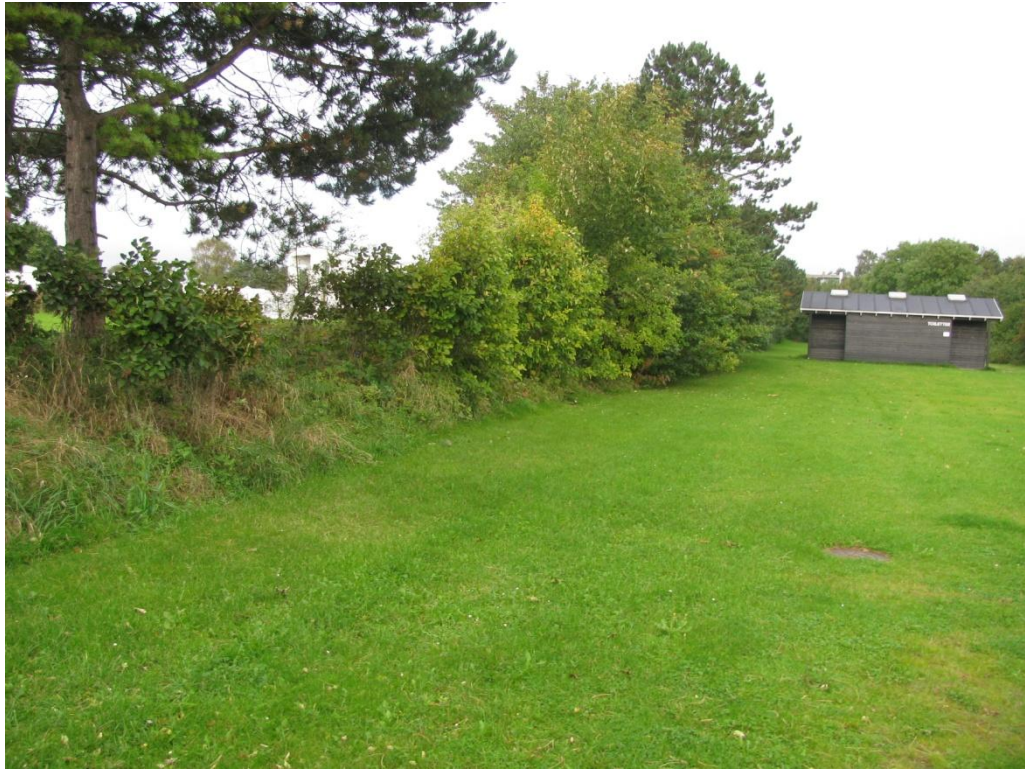
Figur 2.1.3: Del af diget ved Risskov, som forløber fra pumpestationen ved Egå (Åkrogen) til frem til digets ca. st. 200, hvor diget drejer mod syd. Den ca. 200 m lange digestrækning er bevokset med høj trævegetation, hvorfor strækningen er opmålt med Leica totalstation.
