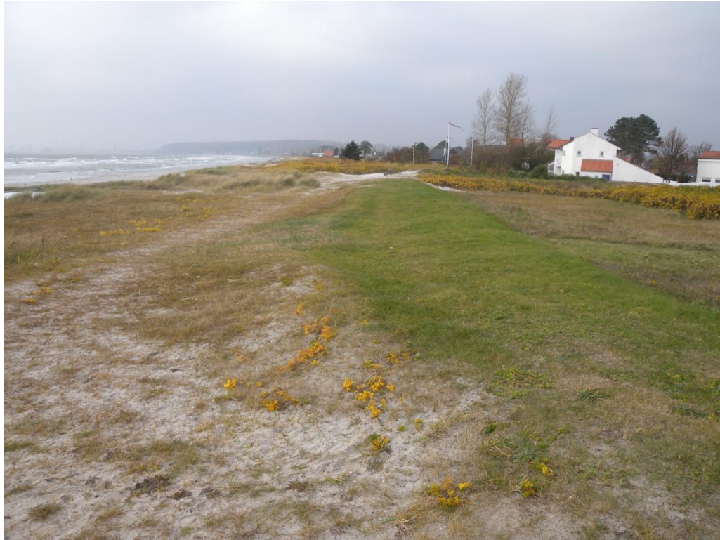
Figur 3.2.8: Foto mod syd af diget ved st. 1942.
