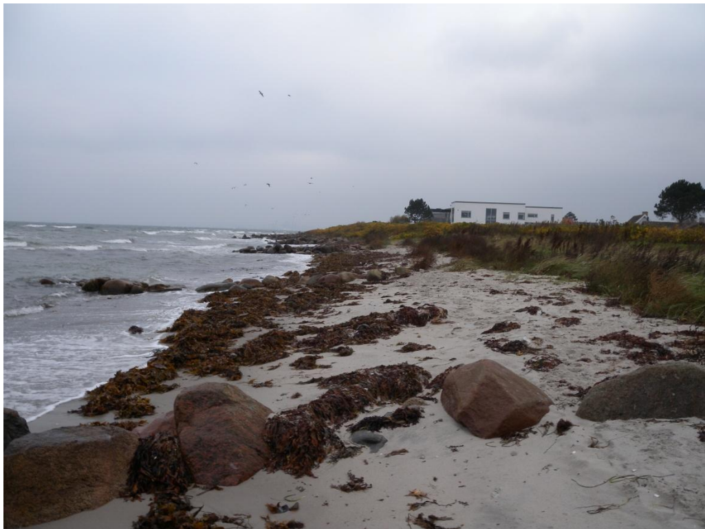
Figur 3.2.5: Foto mod syd af diget ved st. 468.
