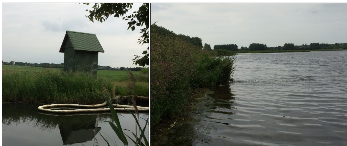
Figur 3-7 Til venstre ses pumpestationen i nedstrøms ende af Gl. Egå mens billedet til højre viser rørudløbet til Egå Engso fra den lille dykpumpe i opstrøms ende af Gl. Egå.
